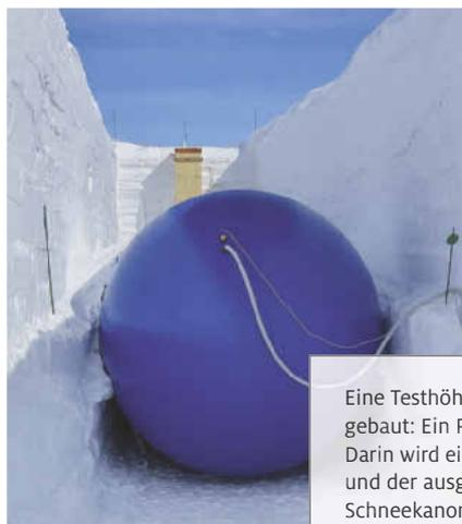
Eine Testhöhle für das Antarktis-Archiv wird gebaut: Ein Pistenbulldozer zieht einen tiefen Graben. Darin wird ein Ballon platziert, den man aufpumpt, und der ausgegrabene Schnee wird mit einer Schneekanone darüber geblasen. Nach ein paar Tagen lässt man die Luft aus dem Ballon entweichen – und eine stabile Eishöhle ist entstanden.
