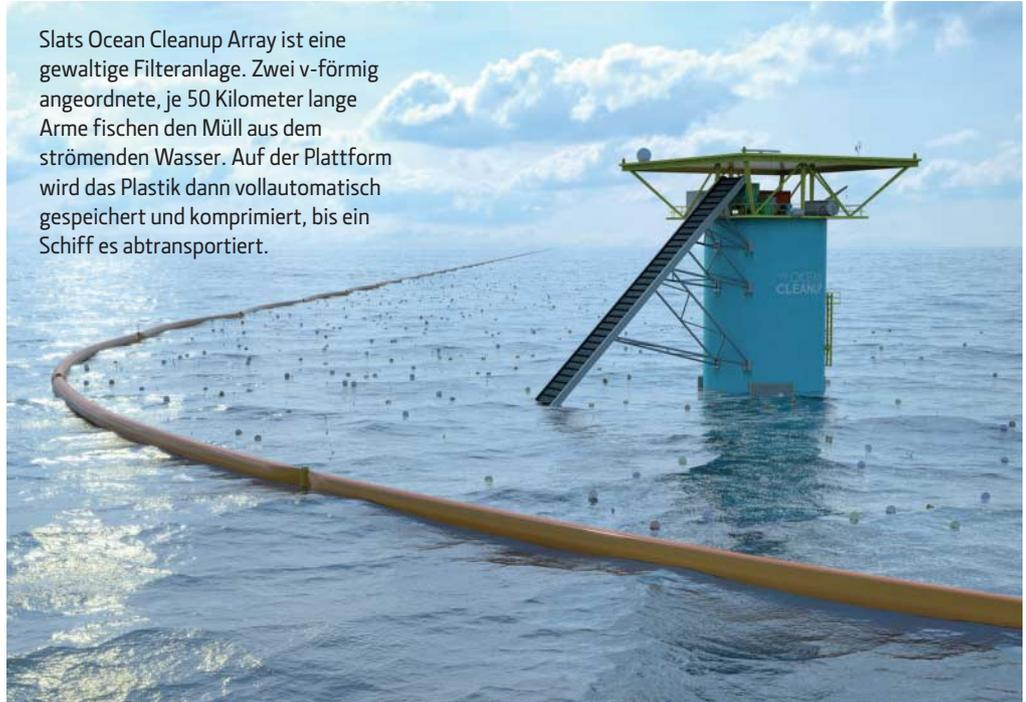
des Vs ist 120 Grad weit geöffnet und exakt so ausgerichtet, dass die Meeresströmung das Wasser und mit ihm den Plastikmüll hineintreibt. Die gefangenen Partikel treiben unaufhaltsam zum Zentrum der Anlage und konzentrieren sich dort. Förderbänder und Schlamm-pumpen fischen sie aus dem Wasser, in einem Stahlbehälter werden sie vollautoma-
